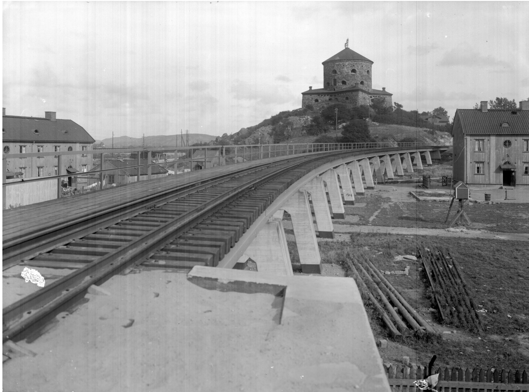
Figur 86: Järnvägsviadukt i Göteborg 1929. Källa: Digitalt museum.
