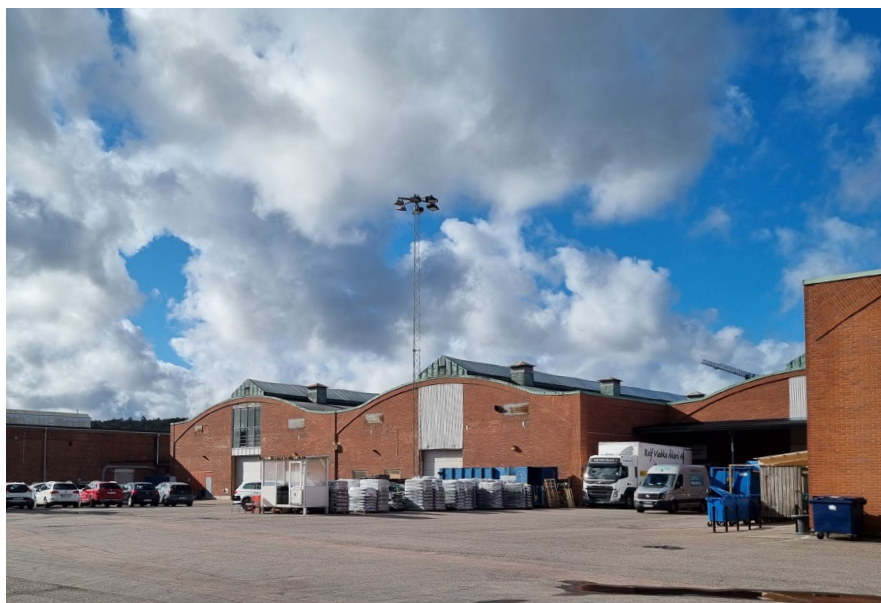
Figur 21: Wezäta-Melins välvda tak syns bäst från baksidan.
