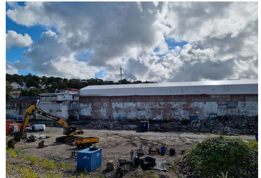
Figur 36: Vid Forsåker pågår just nu ett omfattande förändringsarbete.
