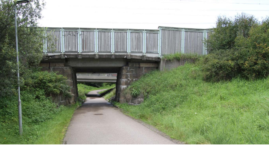
Figur 114: Gångport under väg i Åbromotet.
