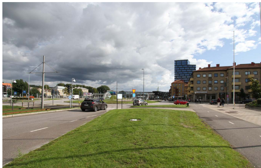
Figur 98: Foto söderut längs Göteborgsvägen, i fonden skymtas Mölndals bro.
