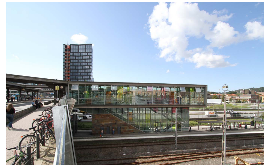
Figur 102: Foto från Mölndals bro över spårområde och resecentrum.
