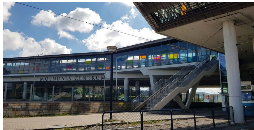
Figur 99: Mölndals bro. Vy från nordvästra sidan av stationen.
