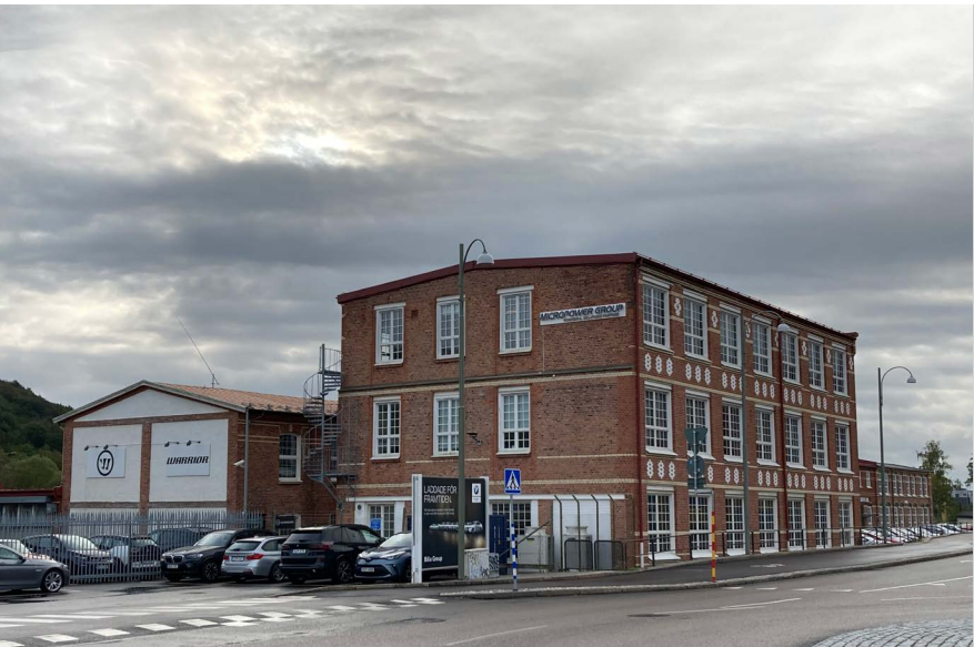
Figur 85: Krokslätts fabriker. Vy från Göteborgsvägen.
