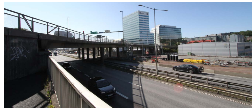
Figur 73: S:t Sigfridsbron, vy mot sydväst. I bild syns väg E6/E20 samt kontorsverksamheter.
