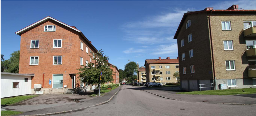
Figur 76: Låga lamellhus i Kallebäck.
