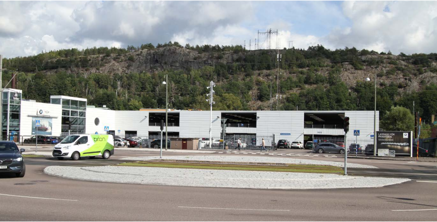
Figur 91: Foto österut, taget från Göteborgsvägen. I fonden syns Lackarebäcksfjället.
