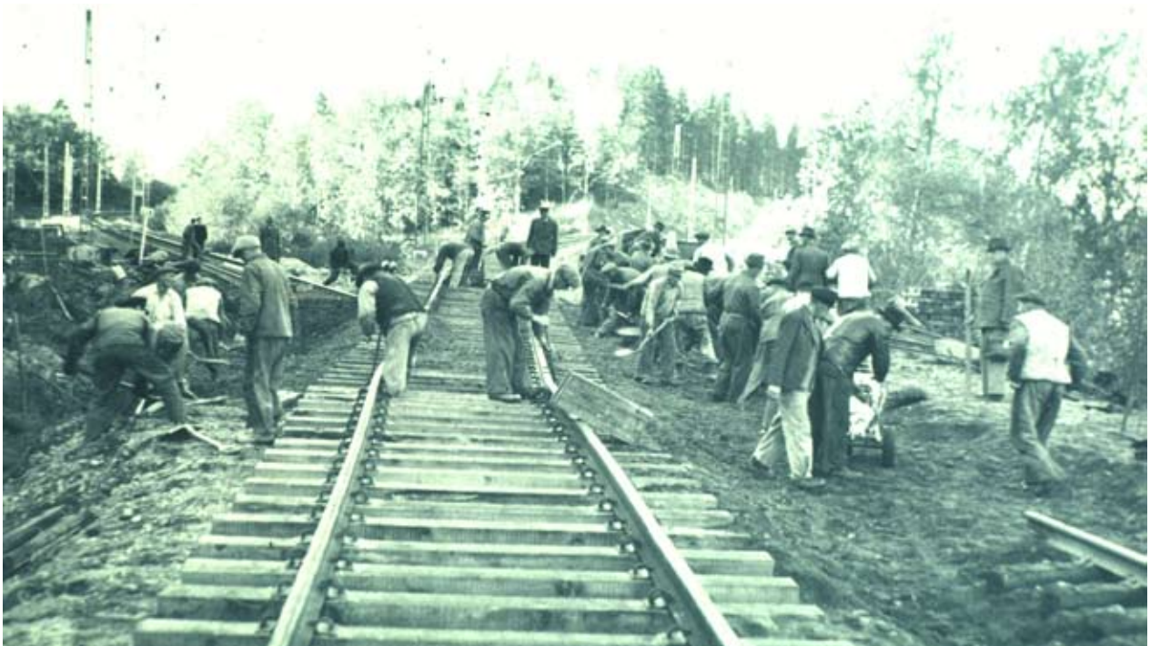
Bild 2.1: Rälsläggarglag vid byggandet av norra stambanan. Foto Banverket.
