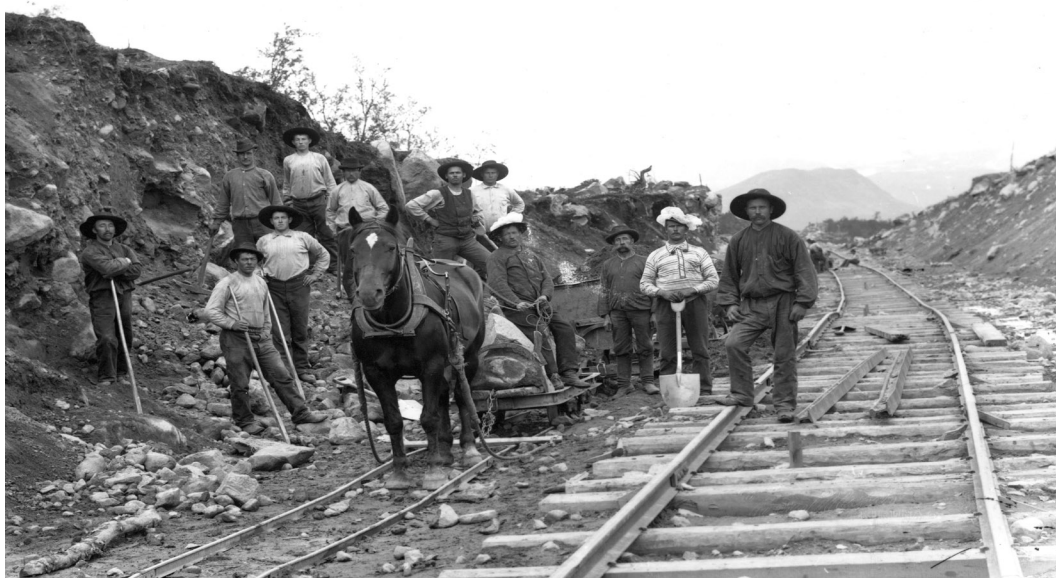
Figur 4.2: Rälsläggarglag vid järnvägsbygge.
