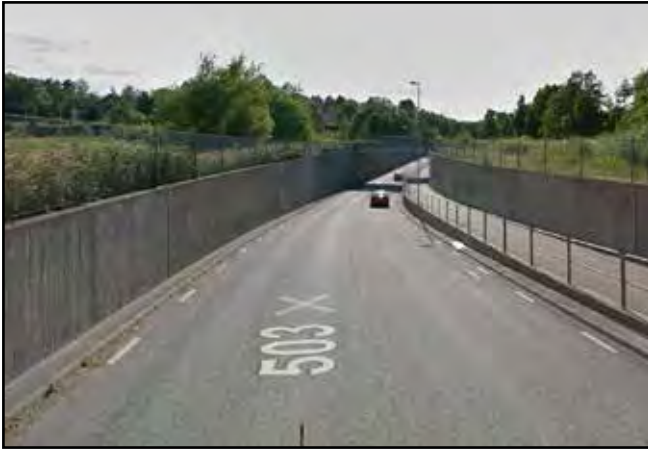
4.2:2 Exempel på utrymmeskrävande vägport under järnväg i Lindome (Bild: Google).
