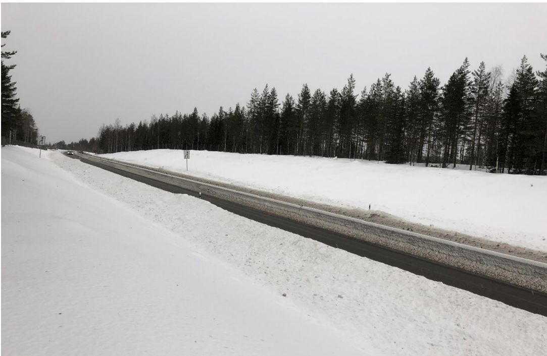
Figur 4-2. Utsikt över E4 från släntrönen i skärningen där faunapassagen föreslås placeras. Vy från öster.
