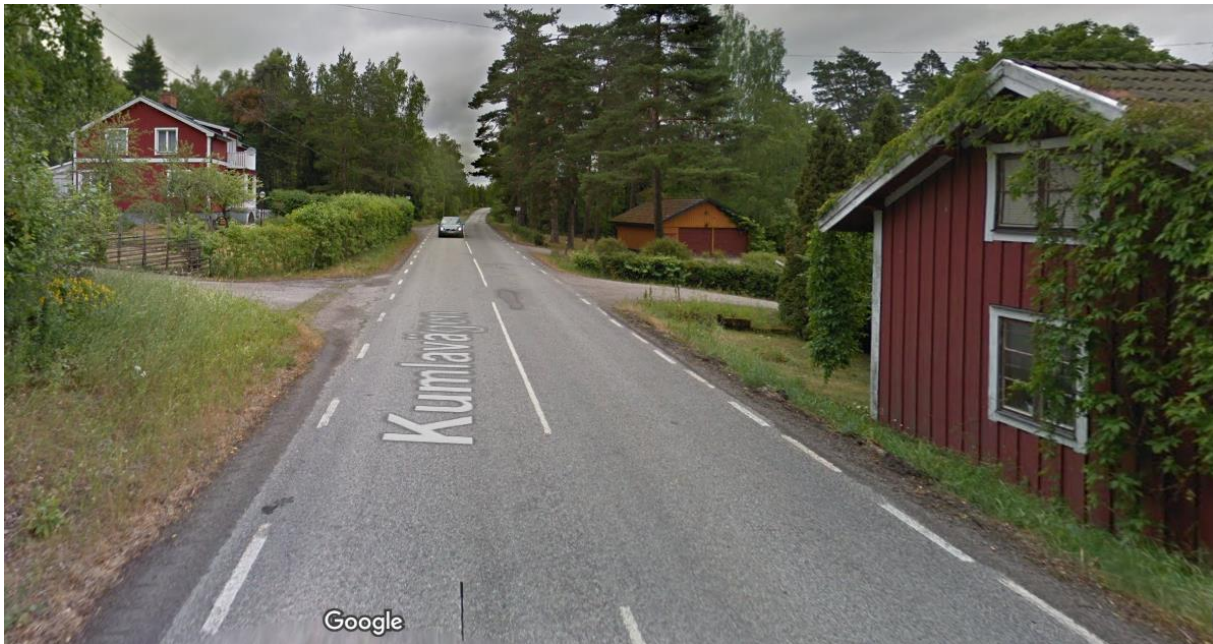
Figur 5:2 Bebyggelse utmed Väg 723.
