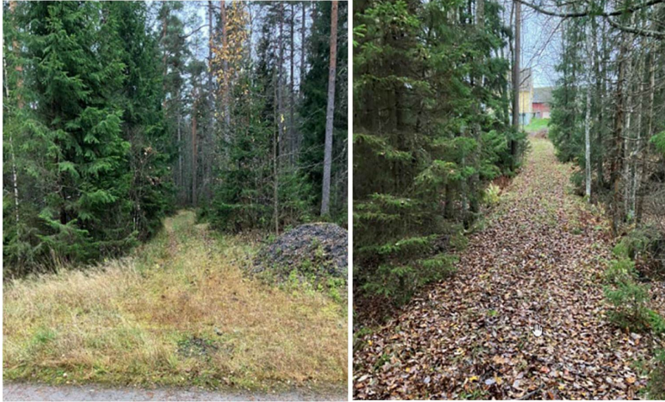
Figur 11. Fotona visar befintlig överväxt skogsväg vid läget för den västra mellanblockskiosken. Högra bilden visar vägens riktning mot järnvägen, där det finns en slopad plankorsning.
