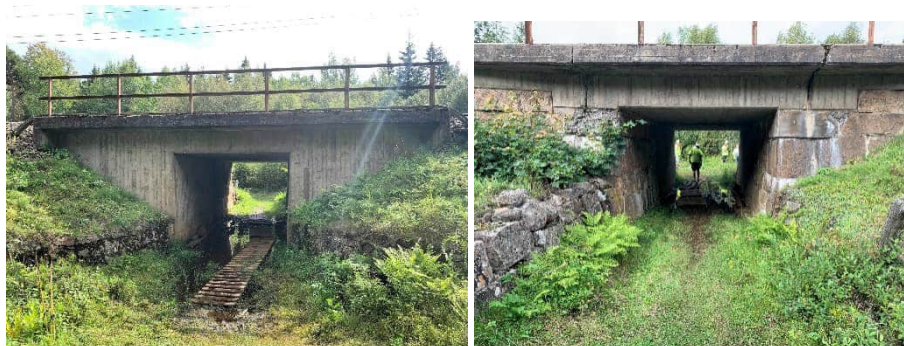
Figur 8. Till vänster norra bron byggd 1951 och till höger södra bron byggd 1857, med ny överbyggnad 1951.
