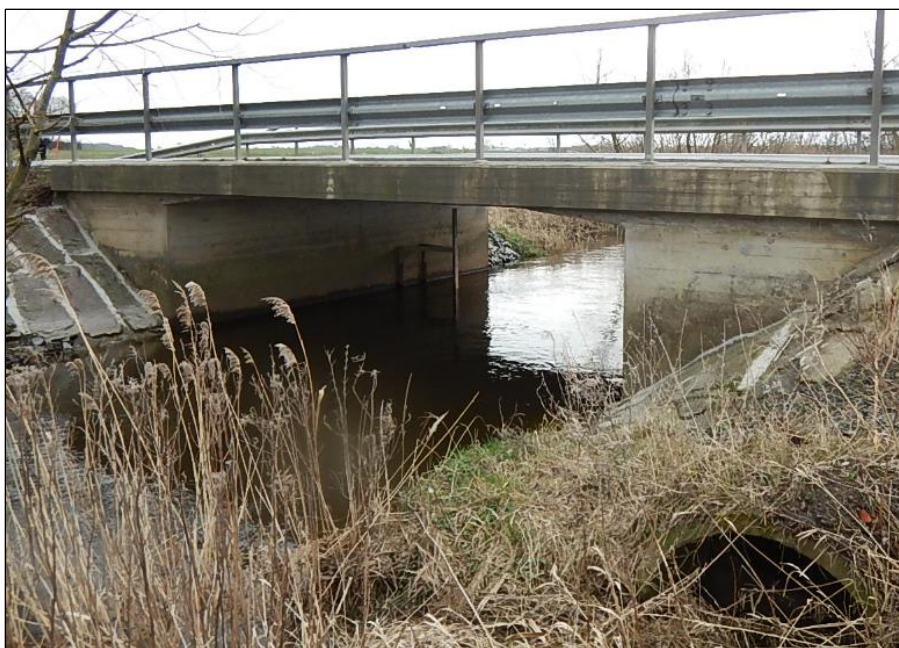
Figur 10. Foto av befintlig vägbro över Vinne å. I det nedre högra hörnet syns ingången till ett av betongrören. Röret går hela vägen till andra sidan bron bakom rambenet och det finns ett likadant rör vid det andra landfästet.
