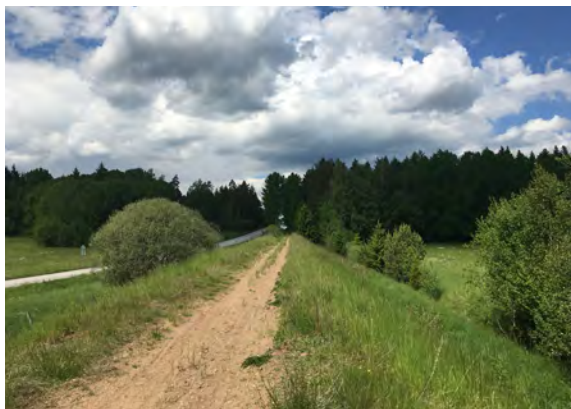
Figur 2.21 Den gamla banvallen vid väg 280.
