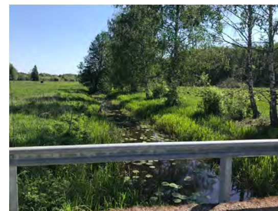
Figur 3.28 Befintlig bro över vattendrag vid dalgången längs med väg 982
