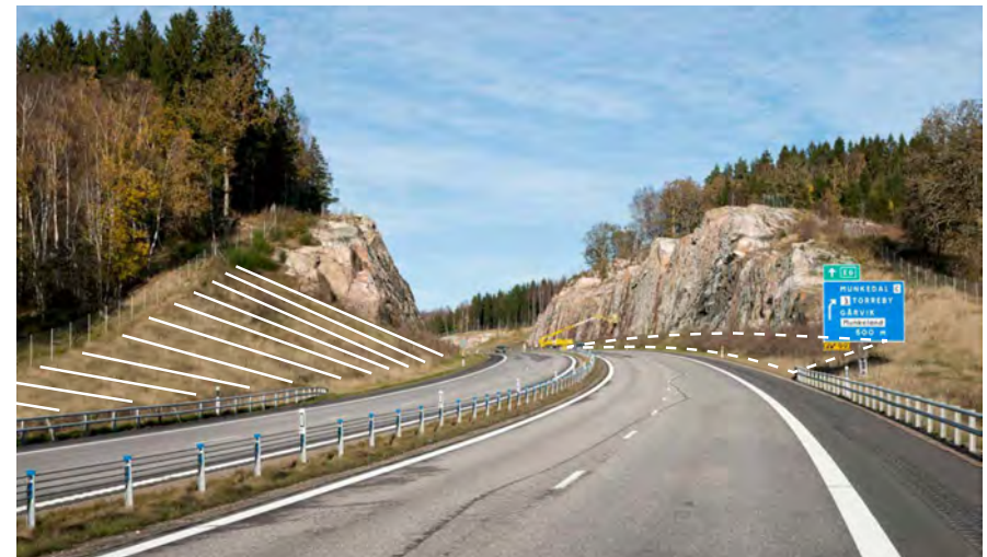
Figur 3.12 Propellerbladslänt i övergång från skärning till markläge
