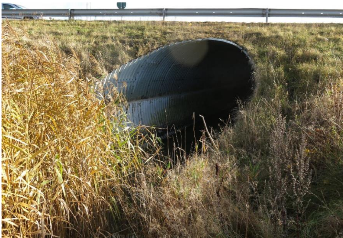
Figur 3. Foto befintlig rörbro för Hasslebäcken under E20.
