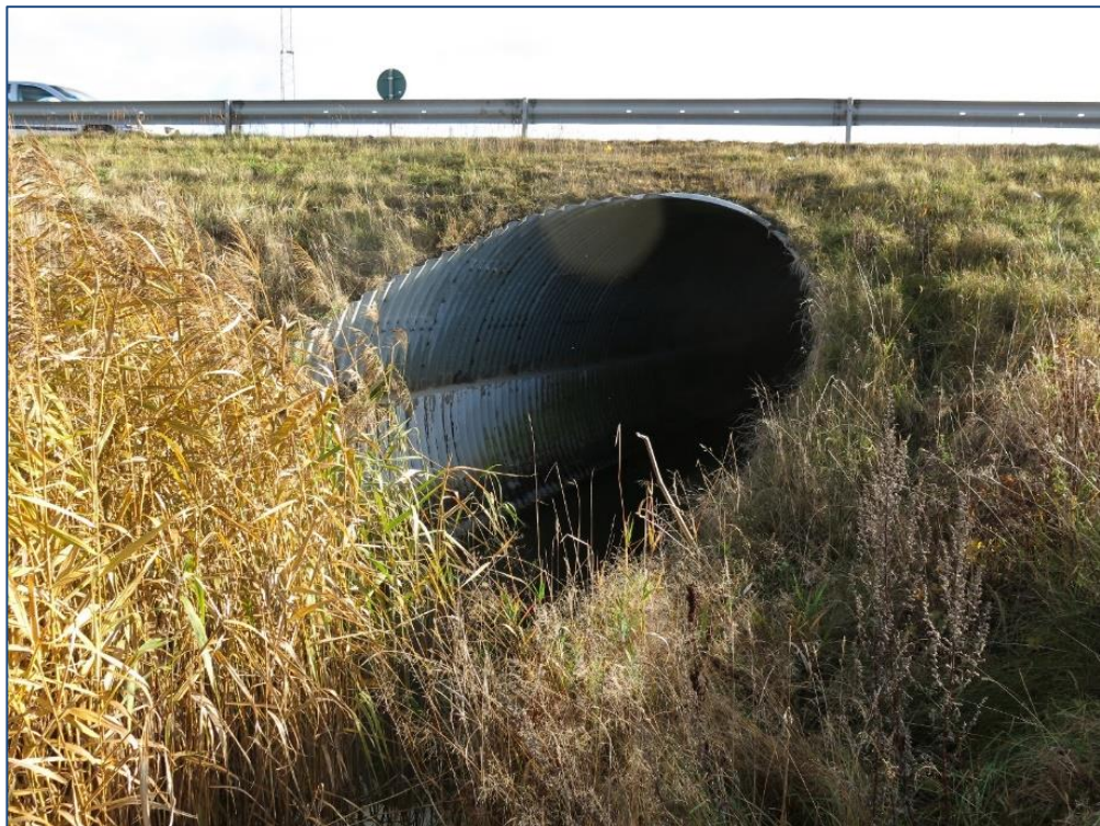
Figur 21. Bro över Hasslebäcken (Trafikverkets förvaltningssystem för byggnadsverk, BatMan).
