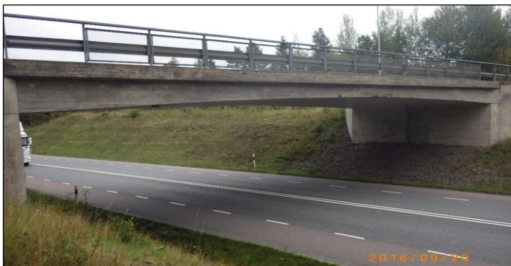
Figur 19. Bro över E20 vid trafikplats Brodderud (Trafikverkets förvaltningssystem för byggnadsverk, BatMan).
