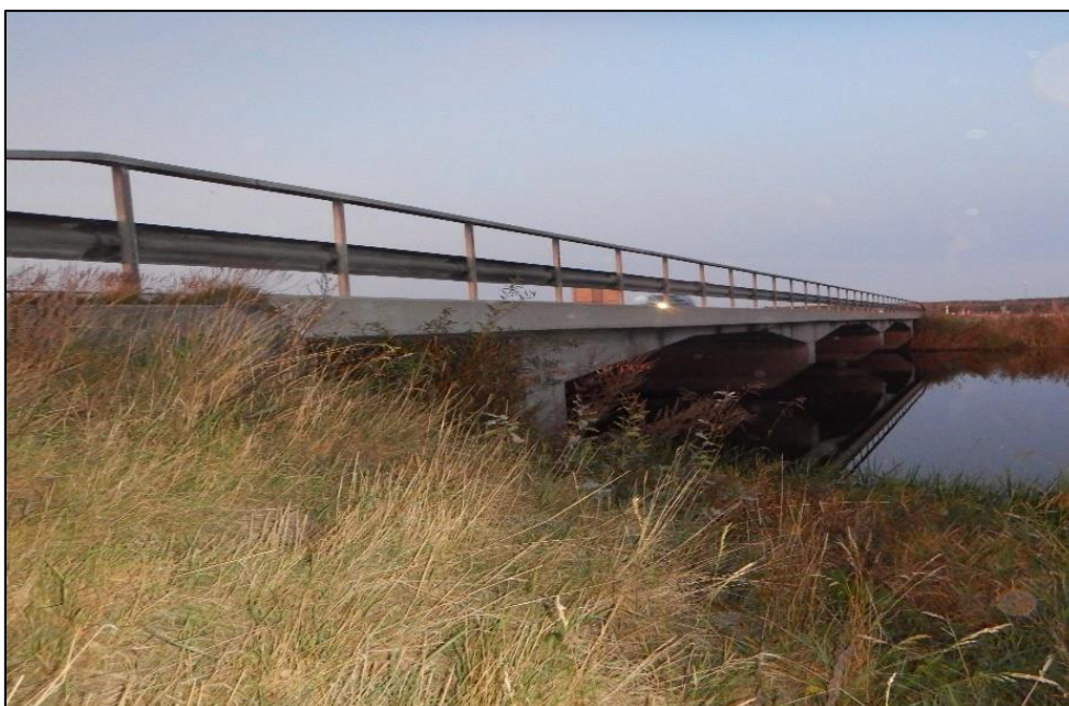
Figur 18. Bro över Tidan (Trafikverkets förvaltningssystem för byggnadsverk, BatMan).
