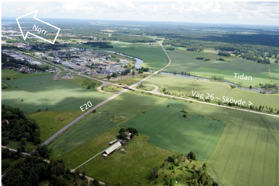
Figur 10. E20 förbi Mariestad. Öppet flackt landskap kring Tidan. Flygfoto från sydost. Trafikplats Haggården i centrum av bilden. Flygfoto: Pekka Kärppä.
