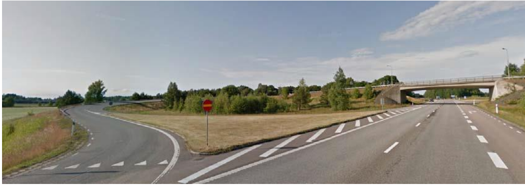
Figur 8. Befintlig E20 vid trafikplats Ullervad (Från Samrådshandling - Val av lokaliseringalternativ).
