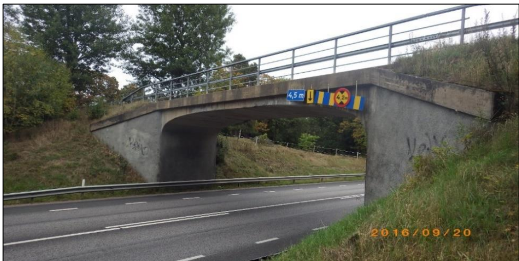
Figur 16. Bro över E20 vid Hindsberg (Trafikverkets förvaltningssystem för byggnadsverk, BatMan).
