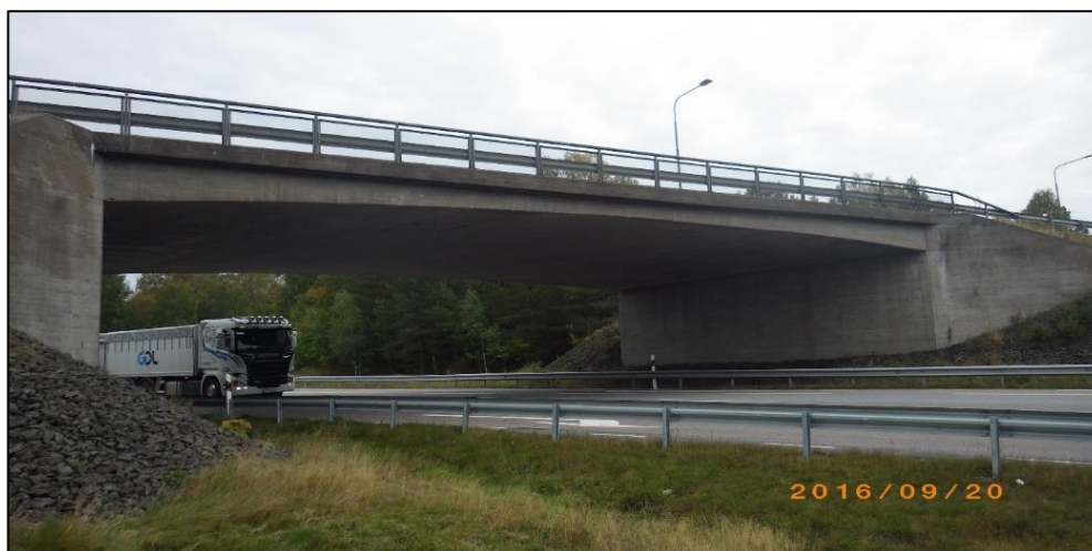
Figur 19. Bro över E20 vid trafikplats Ullervad (Trafikverkets förvaltningssystem för byggnadsverk, BatMan).
