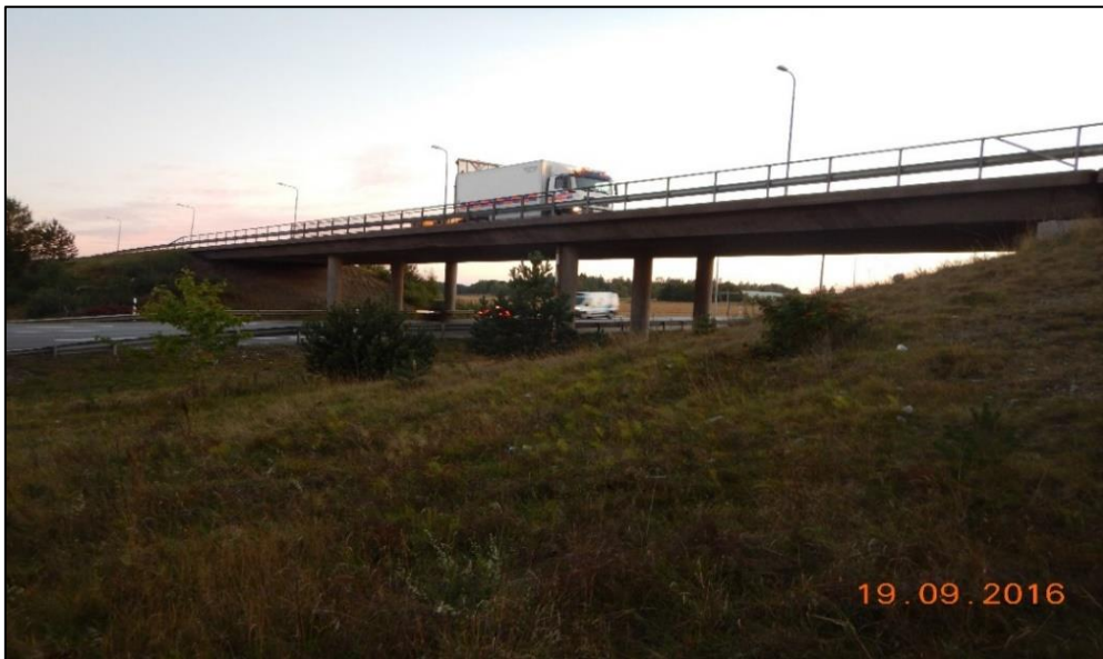
Figur 17. Bro över E20 vid trafikplats Haggården (Trafikverkets förvaltningssystem för byggnadsverk, BatMan).
