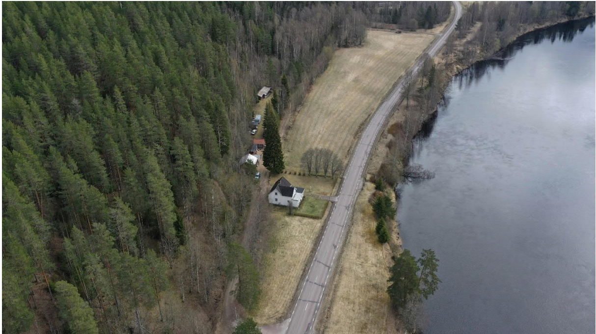
Figur 17. Bostadshuset på norra delen av sträckan. Till vänster om huset syns den gamla färdvägen. Foto: Sweco 2020-04-28.
