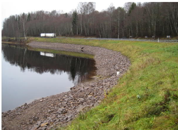
Figur 23. Fotografi (till vänster) kommer från anläggande av erosionsskydd vid Norra Älvkullen 2010. Foto visar utläggande av material och skapande av tillfällig körbar yta. Fotografi (till höger) visar ett färdigställt kombinerat erosionsskydd utfört på väg 62 vid Höje (norr om Munkfors). Erosionsskyddet i bilden ovan har inte naturanpassats.
