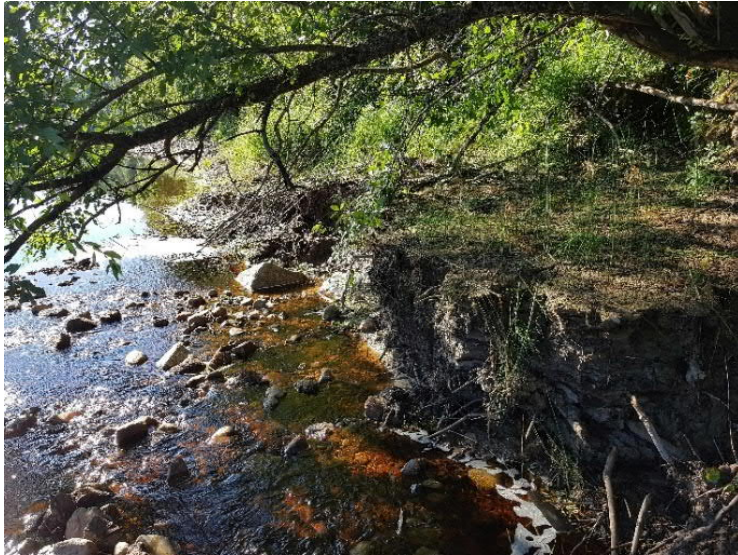
Figur 9. Älvslänt Södra Fastnäs. Foto: Sweco (2018-08-09).
