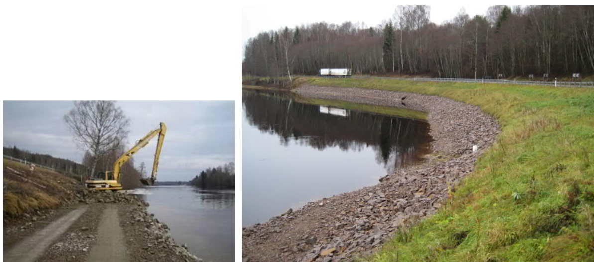
Figur 23. Fotografi (till vänster) kommer från anläggande av erosionsskydd vid Norra Älvkullen 2010. Foto visar utläggande av material och skapande av tillfällig körbar yta. Fotografi (till höger) visar ett färdigställt kombinerat erosionsskydd utfört på väg 62 vid Höje (norr om Munkfors). Erosionsskyddet i bilden ovan är inte naturanpassat.
