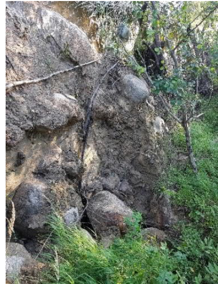
Figur 8. Älvslänt Södra Fastnäs. Foto: Sweco (2018-08-09).
