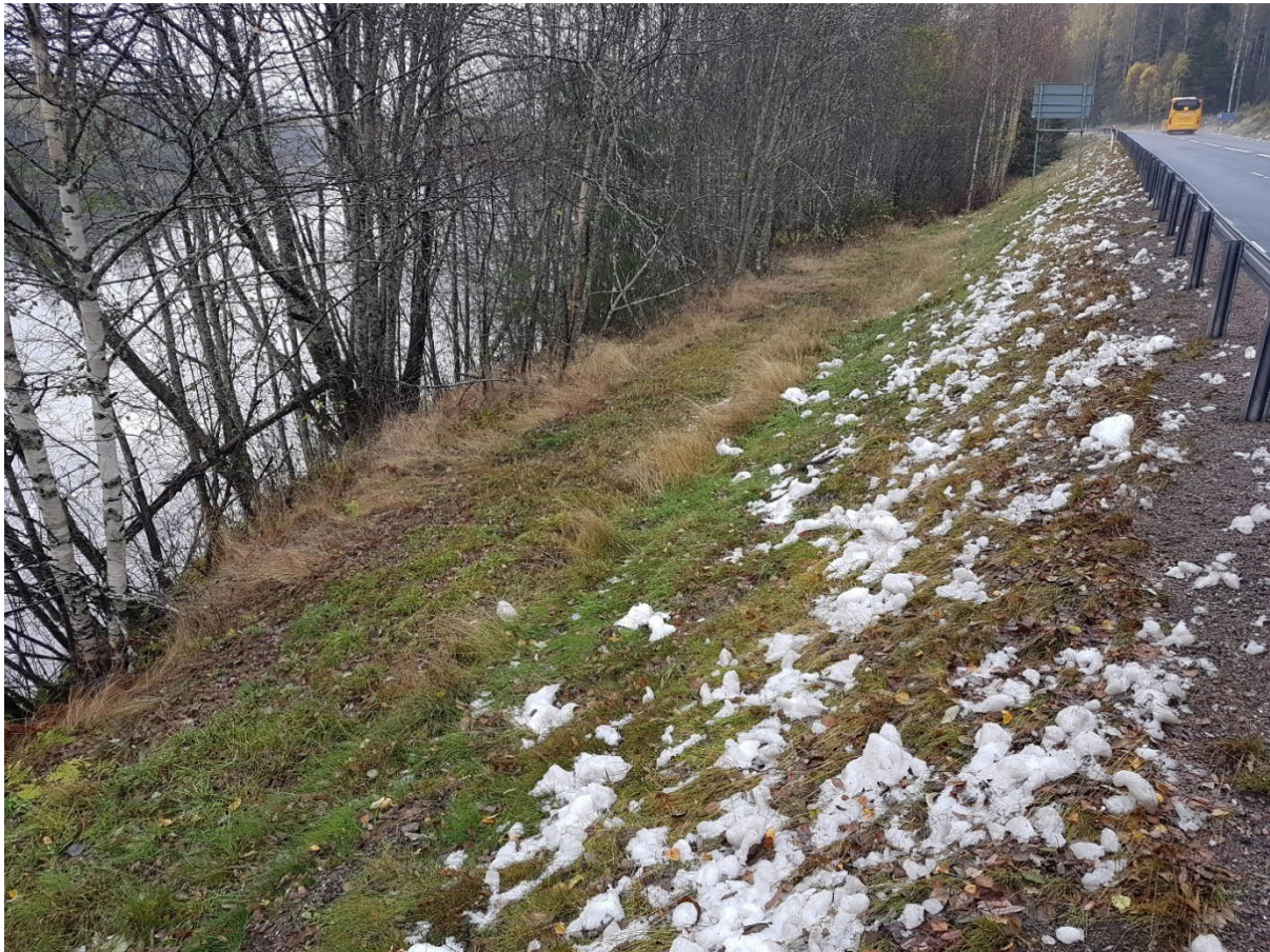
Figur 7. Bankett nedanför väg 62 Södra Fastnäs. Foto: Sweco (2020-01-21).
