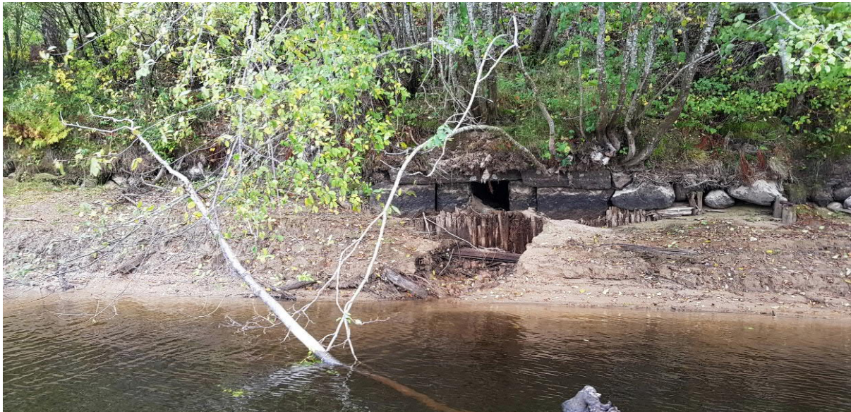
Figur 9. Väg 957 Norra Fastnäs - utlopp stentrumma. Foto: Sweco (2018-09-18).
