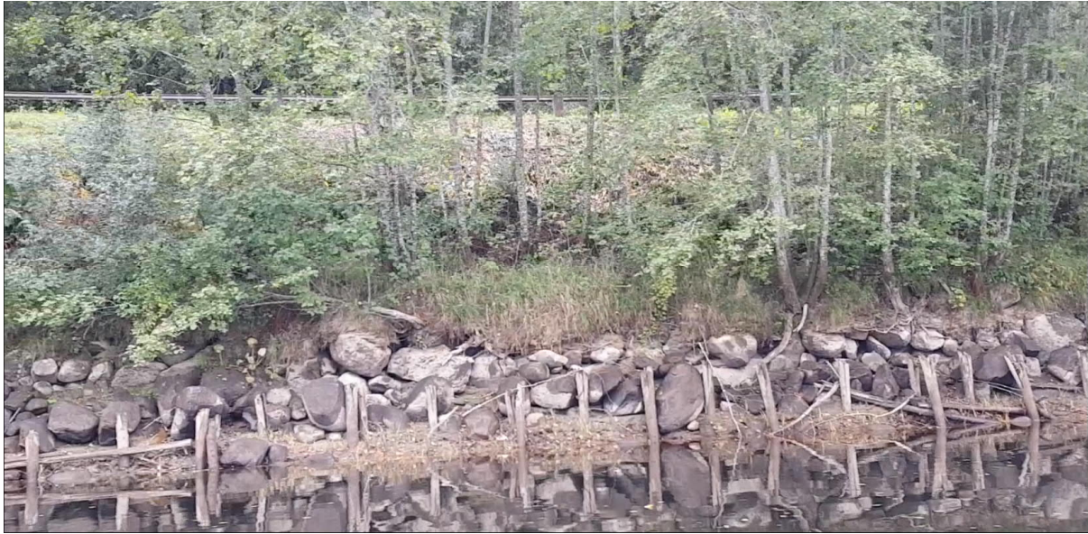
Figur 8. Väg 957 Norra Fastnäs - föråldrad träpalissad. Foto: Sweco (2018-09-18).
