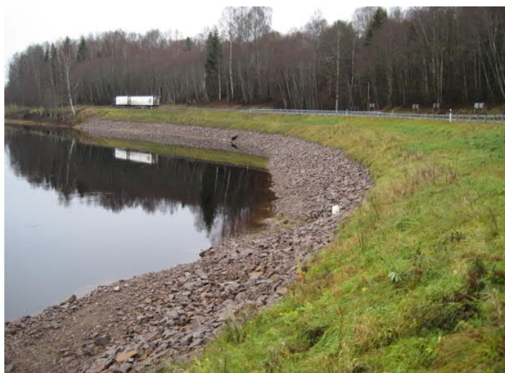
Figur 24. Fotografi (till vänster) kommer från anläggande av erosionsskydd vid Norra Älvkullen 2010. Foto visar utläggande av material och skapande av tillfällig körbar yta. Fotografi (till höger) visar ett färdigställt kombinerat erosionsskydd utfört på väg 62 vid Höje (norr om Munkfors). Erosionsskyddet i bilden ovan har inte naturanpassats.
