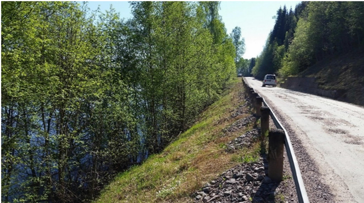
Figur 15. Brant sluttning med växtlighet och stenmur längs väg 957, Norra Fastnäs. Foto: Sweco (2018-05-15).
