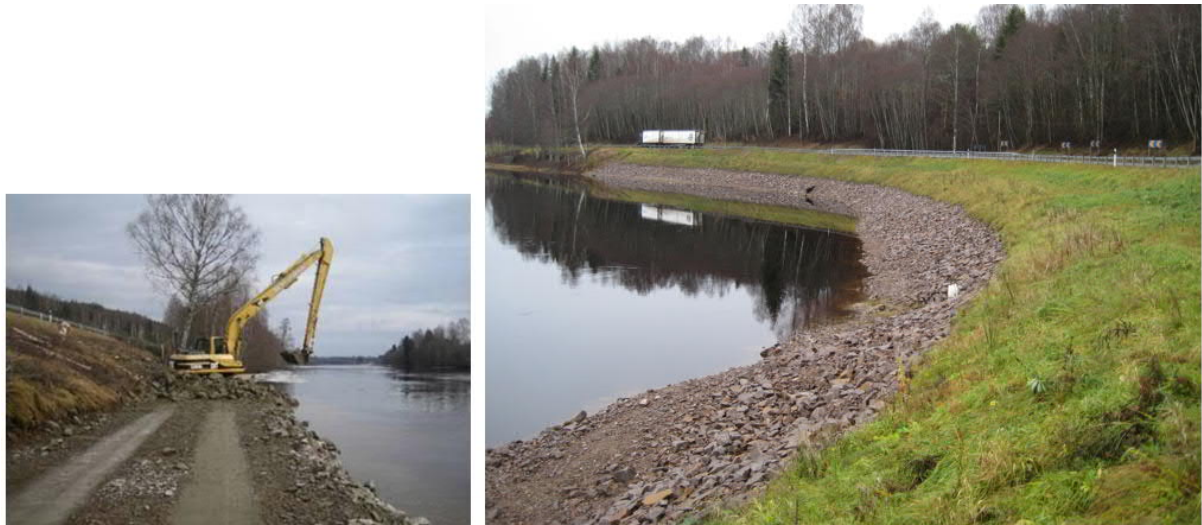
Figur 29. Fotografi (till vänster) kommer från anläggande av erosionsskydd vid Norra Älvkullen 2010. Foto visar utläggande av material och skapande av tillfällig körbar yta. Fotografi (till höger) visar ett färdigställt kombinerat erosionsskydd utfört på väg 62 vid Höje (norr om Munkfors). Erosionsskyddet i bilden ovan har inte naturanpassats.
