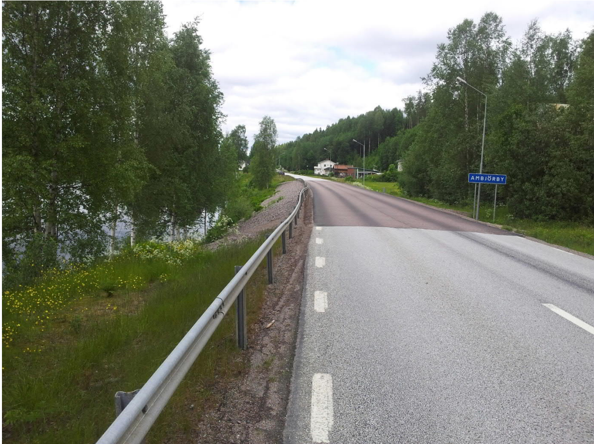
Figur 9. Väg 62 Loftet (efter akut-åtgärd). Foto: Sweco (2015-06-25).
