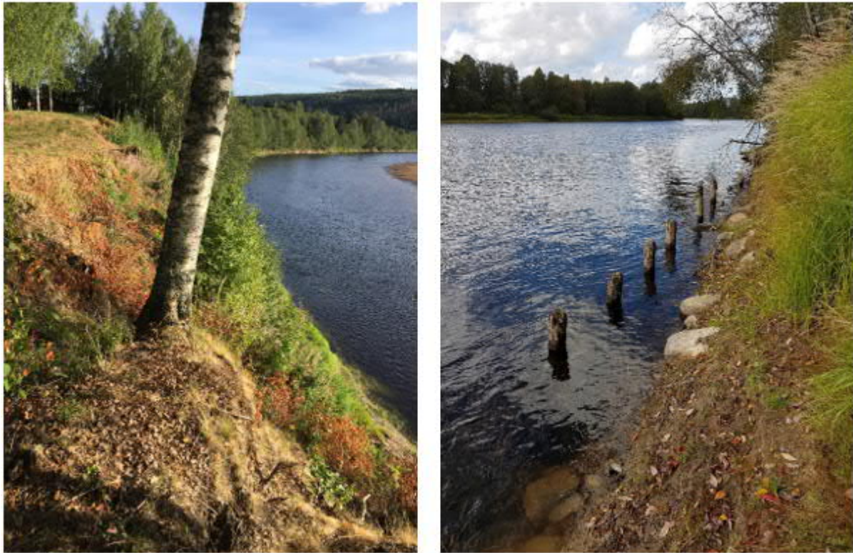
Figur 9. Slänt vid södra delen av åtgärdssträckan. Högra bilden visar foto på befintlig träpalissad. Foto: Sweco (2018-08-09).
