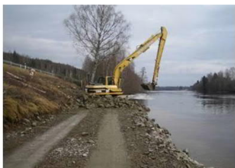
Figur 24. Fotografi (till vänster) kommer från anläggande av erosionsskydd vid Norra Älvkullen 2010. Foto visar utläggande av material och skapande av tillfällig körbar yta. Fotografi (till höger) visar ett färdigställt-kombinerat erosionsskydd utfört på väg 62 vid Höje (norr om Munkfors). Erosionsskyddet i bilden ovan har inte naturanpassats.
