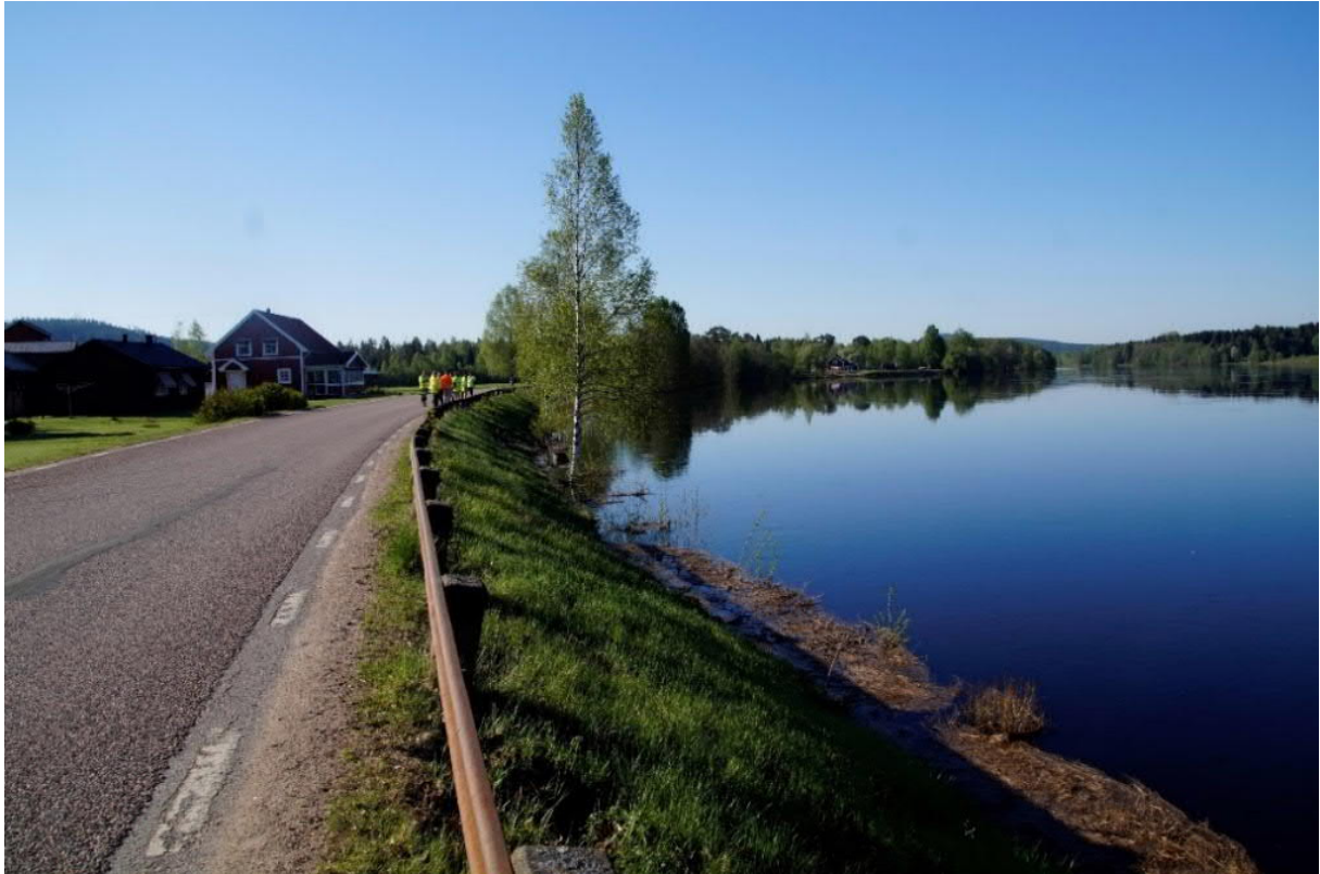
Figur 27. Vy mot söder vid invallningen och väg 931. Foto: Sweco (2018-05-15).
