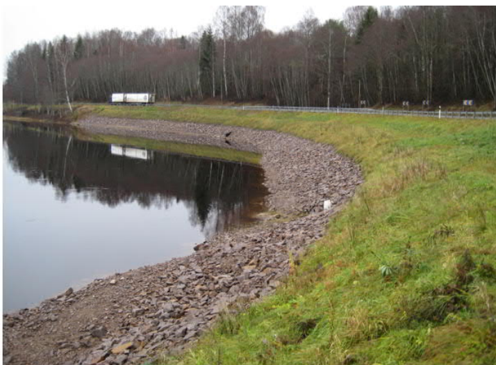
Figur 32. Fotografi visar ett färdigställt kombinerat erosionsskydd utfört på väg 62 vid Höje (norr om Munkfors). Erosionsskyddet i bilden ovan har inte naturanpassats.
