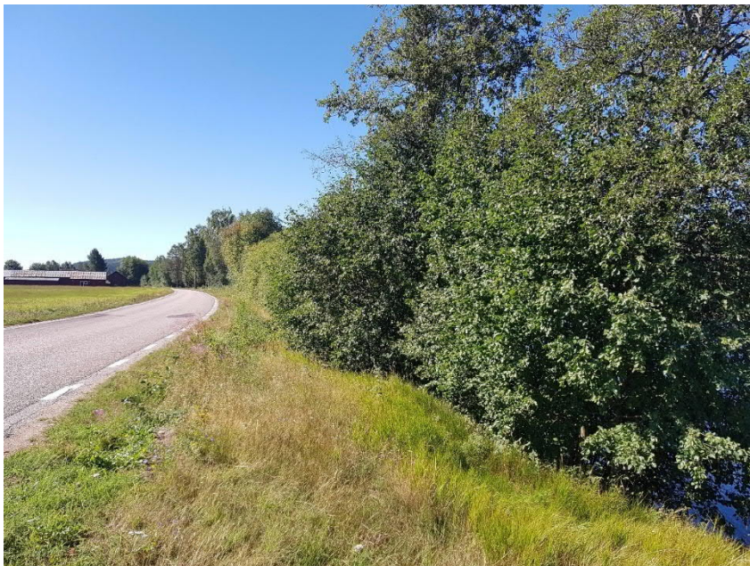
Figur 7. Väg 931 Bergsäng. Foto: Sweco (2018-05-15).
