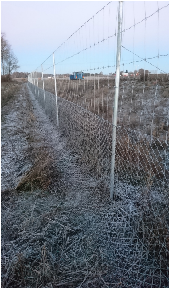
5.2:8 Exempel på faunastängsel, med utvikt finmaskigt nät..
