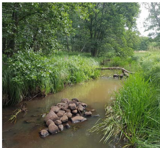
5.2:3 Dalaån väster om E20. Fiskevårdsåtgärder i form av utläggning av sten syns i bildens främre kant.
