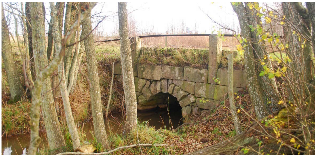
Befintligt utseende på den gamla stenvalvsbron med stengardister och gammalt räcke.
