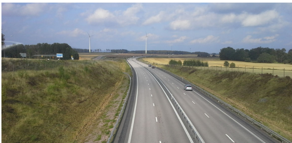
Både norr om och söder om vägsträckan är E20 ett storskaligt, modernt väglandskap. Vilans trafikplats överst (vid Skara, söder om aktuell vägplan) och Ledsjö underst (ingår i aktuell sträcka). På bilden syns en bit av skärningen genom moränåsen.
