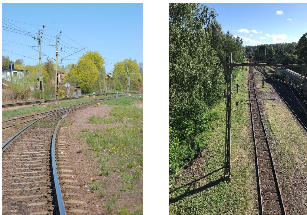
Figur 3. Till vänster fotografi från söder, riktning norrut mot gångfällan. Till höger fotografi taget från Östermalmsgatan, det vill säga bron över järnvägen, och ner över bangården (riktning söderut).
