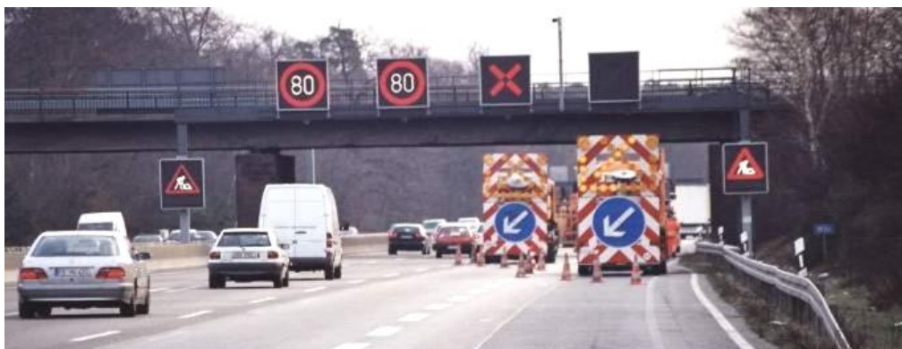
Figur 7.1 Hastighetsnedsättning, körfältsavstängning och varning för vägarbete i Hessen, Tyskland
