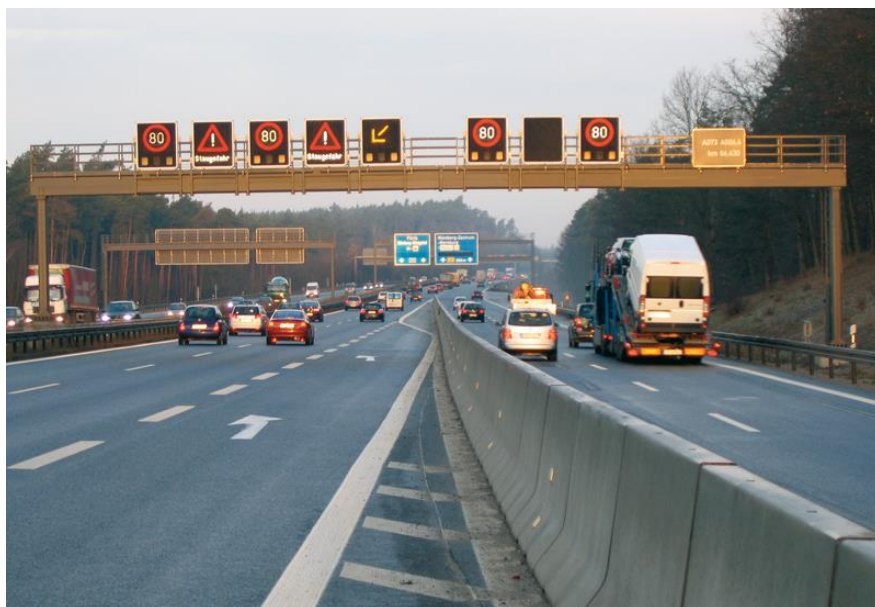
Figur 6.1 Portal i Tyskland med variabla hastighetsvägmärken och varningsmärken (fara för kö)
