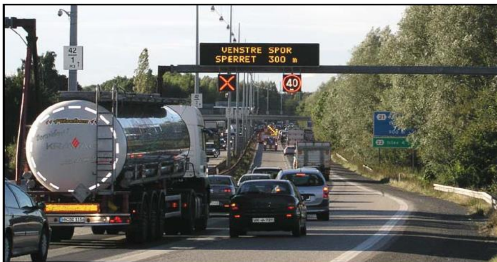
Figur 7.2 Utmärkning av avstängt körfält på M3 i Köpenhamn (Foto från utbyggnadsskedet)
