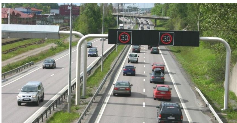
Figur 6.4 Motorvägsregleringssystem på E6 vid Mölndal
