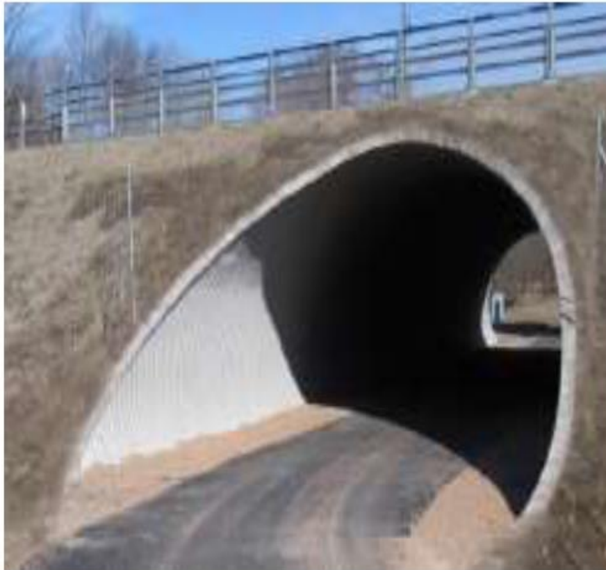
Figur 13 Exempel rörbro (originalbild ViaCon 2009, bilden har redigerats).
