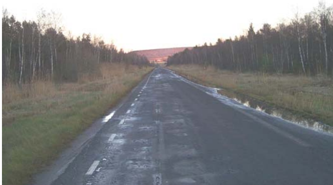
Väg 2858, en typisk AK-väg med rak sträckning, över Åsle mosse, hopplänkad med tvära kurvor. Vägen ligger lågt varför den ofta drabbas av översvämning.
