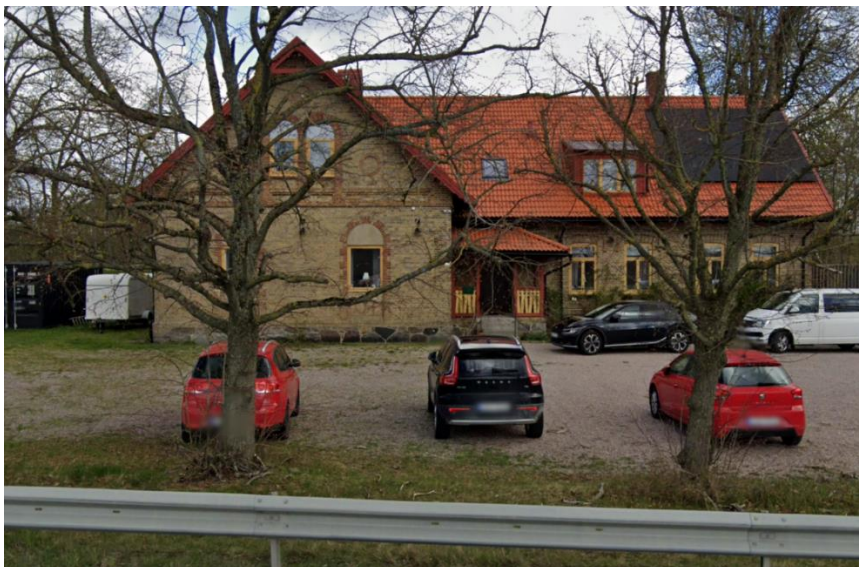
Figur 4.5.6–1. Skolhuset som ligger norr om väg 17 mellan Gullarp och Östra Asmundtorp. Skolhuset omfattas av kulturmiljövården. Bilden tagen mot norr. Bild från Google Maps.
