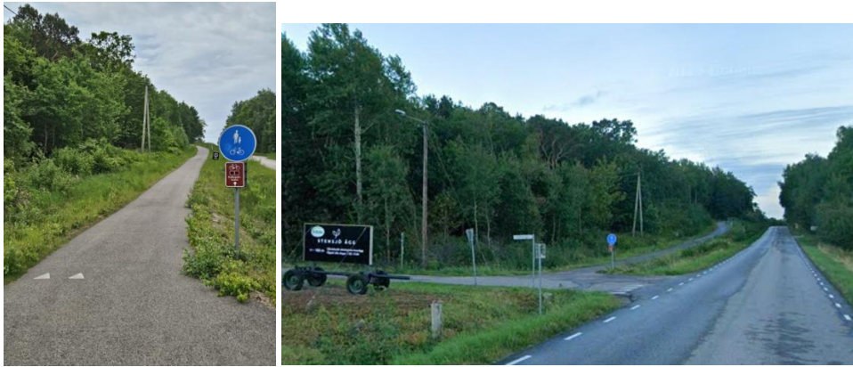
Figur 5. Befintlig gång- och cykelväg i Stensjö (vy söderut). Foto: SYSTRA, 2025.
