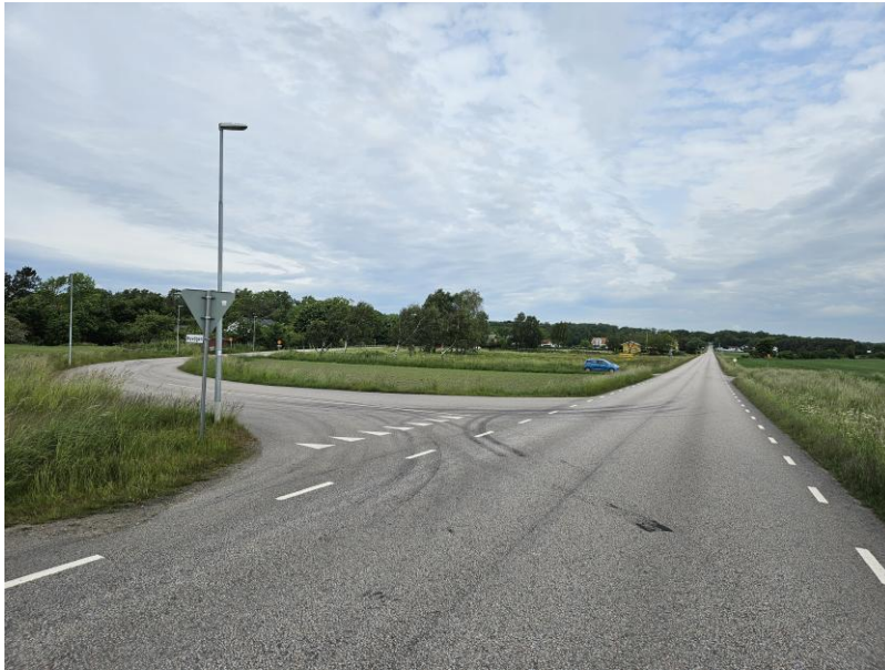
Figur 17. Anslutningspunkt i norr (Ugglarp), där ny gång- och cykelväg ska hänvisas via Byvägen (till vänster i bild), på vägens västra sida. Foto: SYSTRA, 2025.
