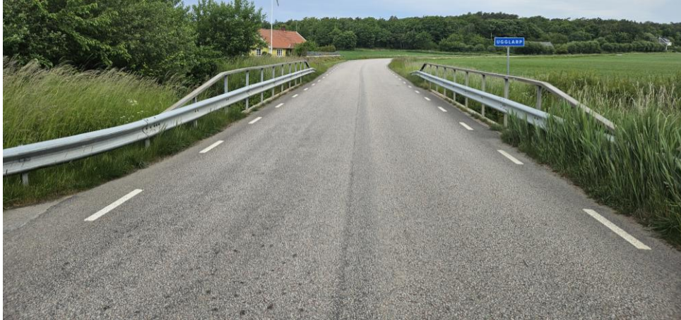
Figur 8. Befintlig vägbro, med fastighet direkt norr om bro på västra sidan.
