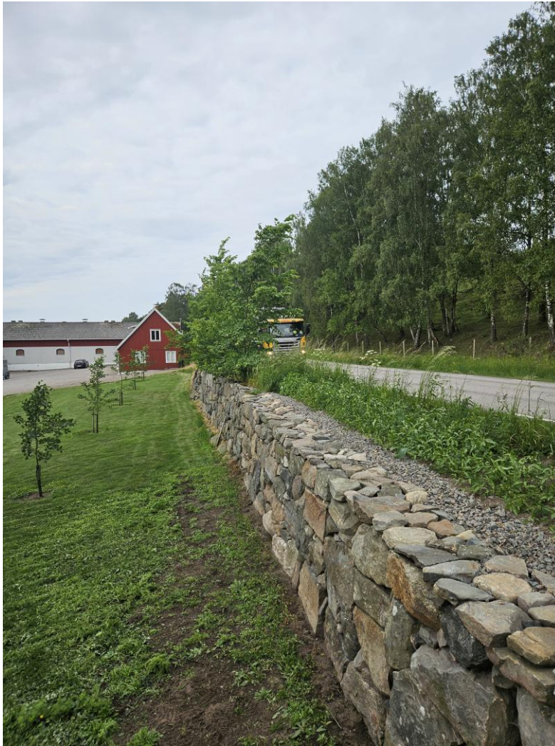
Figur 12. Befintlig stenmur direkt norr om Lassagård, på östra sidan av väg 610 (vy söderut). Foto: SYSTRA, 2025.
