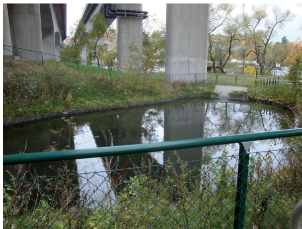
Figur 32 Dagvattendamm under Essingebron på Stora Essingen
