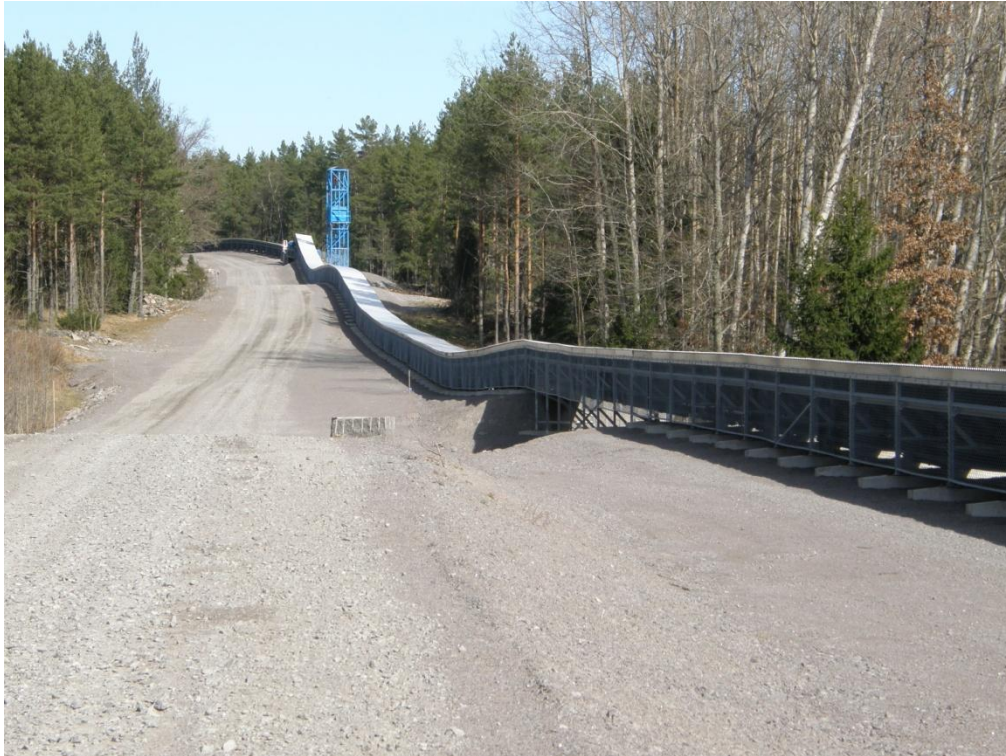
Figur 4.6 visar exempel på transportband för krossat berg vid Nybro Grus anläggning i Flivik. (Foto, Kjell Windelhed.)
