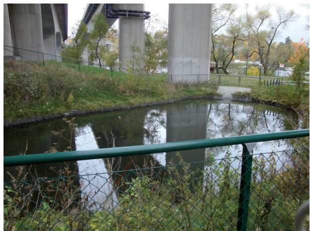
Figur 32 Dagvattendamm under Essingebron på Stora Essingen
