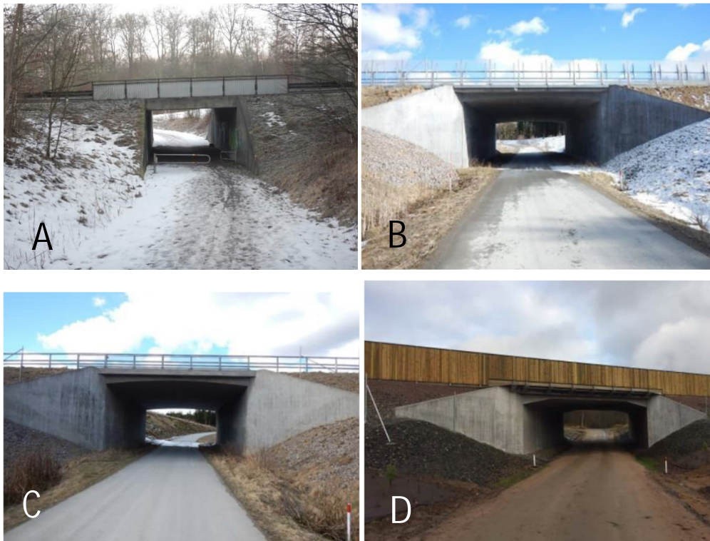
Figur 17. Befintliga passager som bedöms kunna fungera för stora däggdjur. Port A längst upp till vänster, port B (öster om Hörby) längst upp till höger, port C (mellan trafikplatserna Ekeröd och Linderöd) längst ner till vänster samt faunapassagen söder om Linderöd längst ner till höger (D). (Trafikverket, Batman 2023)
