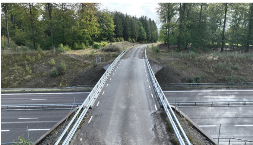
Figur 24. Knopparpsvägen passerar på bro över E22 i vägplanens östra gräns.
