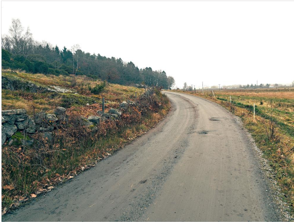
Figur 27. Den äldre vägsträckningen vid Åsebergen samt stenmuren som följer vägkanten.
