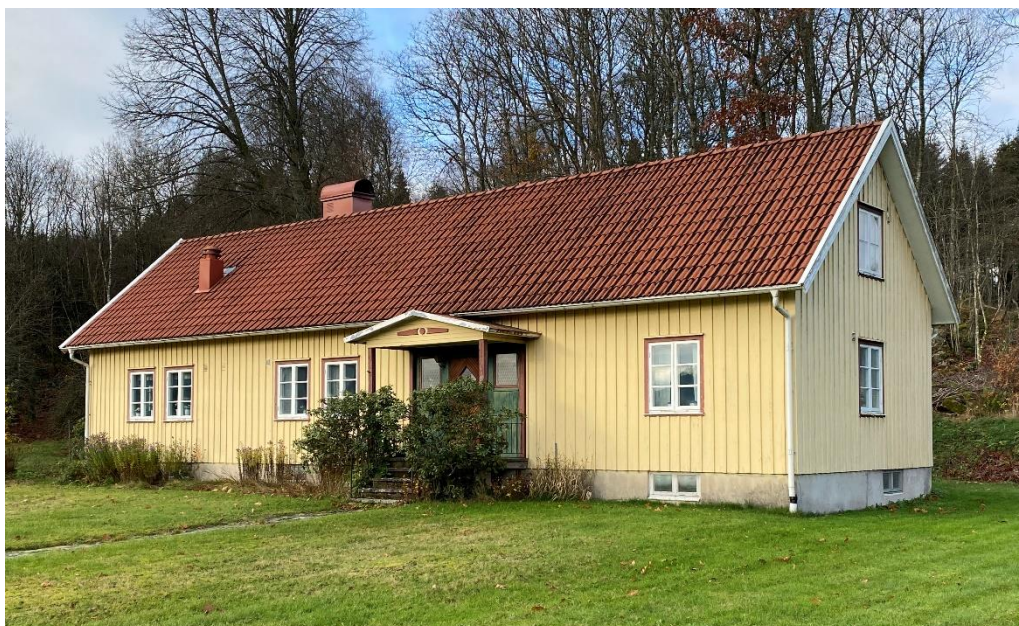
Figur 28. Boningshuset på Flähult 1:2 som föreslås få åtgärder på vägg interiört samt ventiler och fönsteråtgärder på plan 1 och 2.
