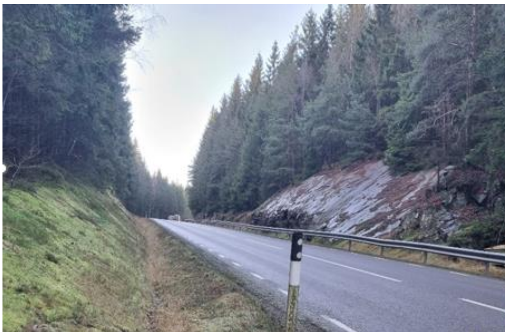
Figur 26. Exempel på bergskärning utmed Hjärtaredsbacken. Fotot kan tjäna som referens på hur beskärningarna kan se ut efter det att åtgärderna är utförda.
