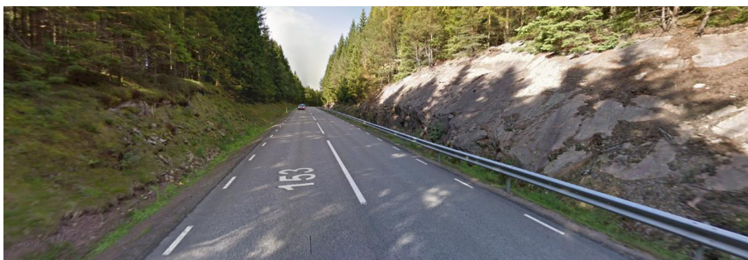
Figur 16. Bergsskärning väster om vägsäl ÖV Hjärtared (bild mot väster, Google Maps).
