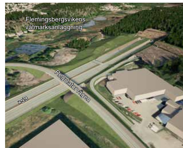
Figur 3.23 Flemingsbergstunnelns västra tunnelmynning sett från väster.
