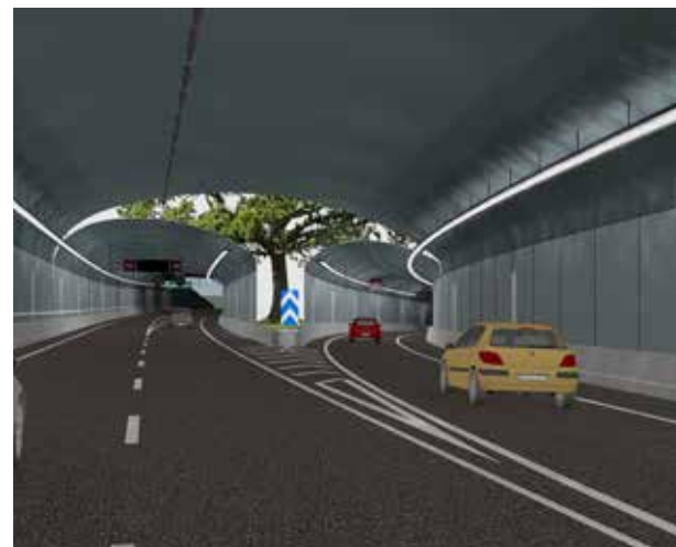
Figur 3.43 Trafikutrymme, förgrening i tunnel.
