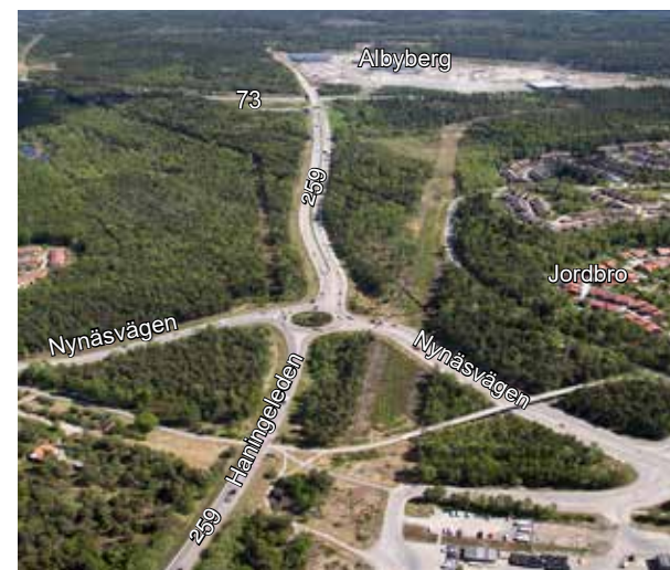
Figur 2.18 Befintlig väg 259 vid Jordbro.
