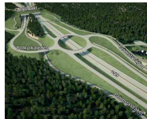
Figur 3.16 Trafikplats Flottsbro sett från sydöst.
