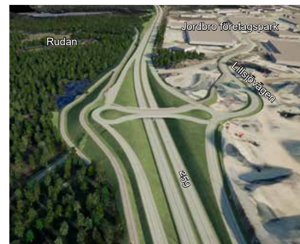
Figur 3.33 Trafikplats Rudan sett från väster.
