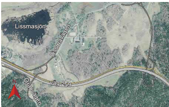
Figur 3.65 Trafikplats Lissma med klöverramper i bergskärning, (13).
