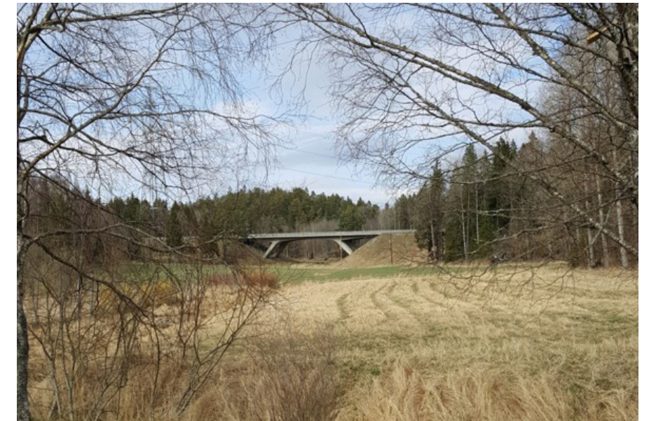
Figur 6.4.12. Ekedalsbron, som är så pass stor att alla typer av djur ges möjlighet att röra sig tvärs befintlig väg 259 på ett säkert sätt. Vy från sydväst. Foto: Tyréns.
