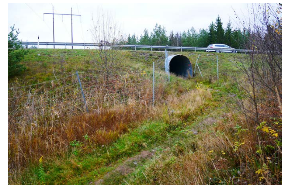
Figur 6.5.16. Sörmlandsleden i rörtunnel under befintlig väg 259. Foto: Tyréns.
