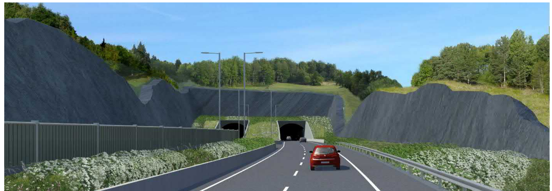
Figur 6.4.4 Glömstatunnelns östra mynning.
