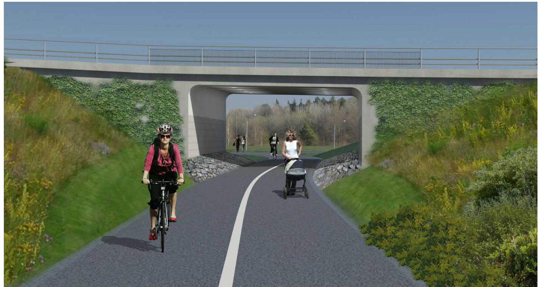
Figur 5.4.1 Vingmurar orienteras parallellt med väg ovanför.
