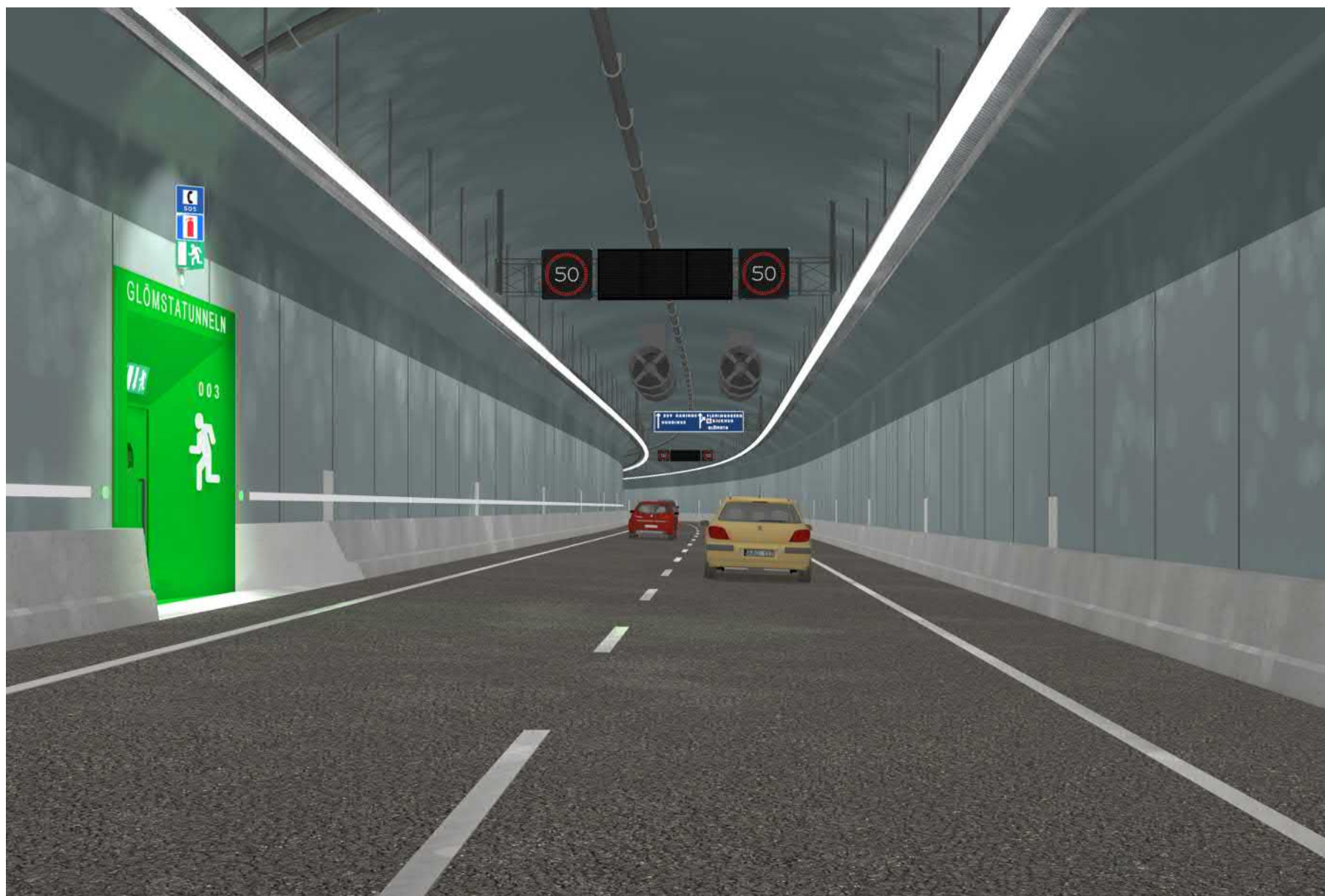
Figur 5.2.1 Exempel på tunnelrum med utrymningsportal till vänster, barriärer, belysning och intuitiva avståndsangivelser.
