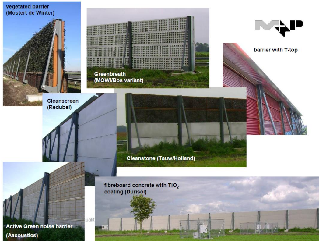
Figur 10. Olika skärmar vars effekt på NO x , NO 2 och PM10 studerats av Hoogwerff et al. (2010).
