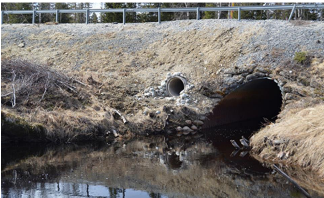
Figur 20. Torrtrumma placerad i linje med vattenförande trumma. Ur Trafikverkets rapport Faunapassager för utter och medelstora däggdjur.
