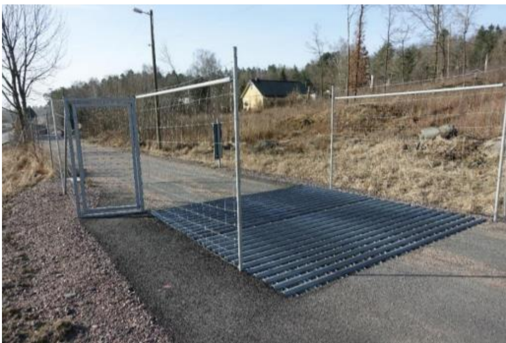
Figur 22. Viltstängsel anslutet till färast vid enskild väg (Trafikverket, 2019).
