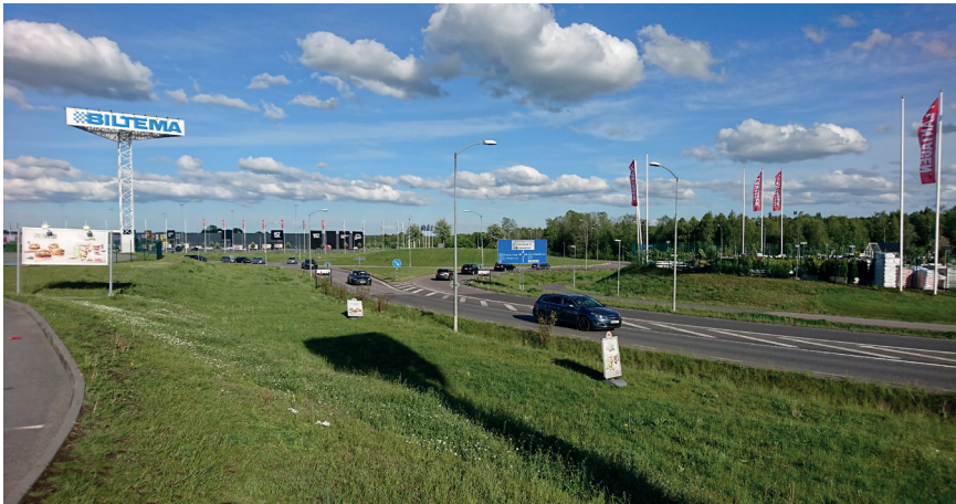
Bild 3. Många vertikala element som till exempel belysningsstolpar, flaggor och stora höga reklamskyltar gör vägrummet rörigt.
