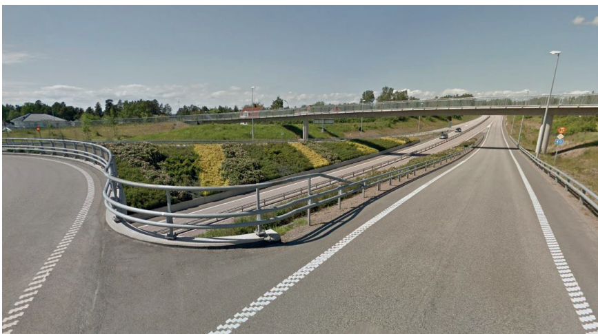
Bild 17. Exempel på rörräcken som ger ett lätt och luftigt intryck. (Google)
