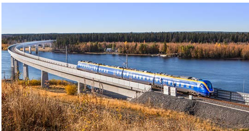
Figur 4.6.2. Bro med bullerskyddsskärm på Botniabanan
