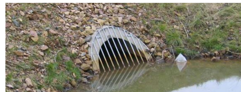
Figur 4.1.7. Exempel på trumöga med galler
