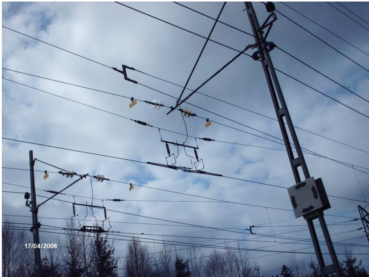
Bild 7. Sektionsisulator vid strömbegränsningstavla, av förare ofta benämnd "kälke".
