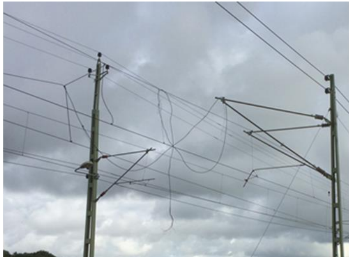
Bild 1. Till vänster strömbegränsningstavla, till höger nedriven kontaktledning.
