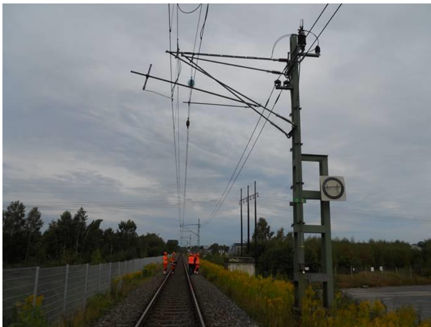
Bild 6. Reparation vid kontaktledningshaveri på skyddssektion med nedkopplingstavla.
