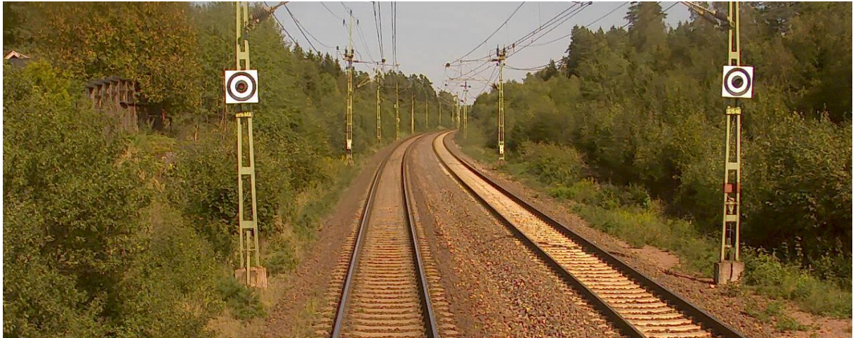
Bild 5. Nedkopplingstavlor med släckt signallampa.
