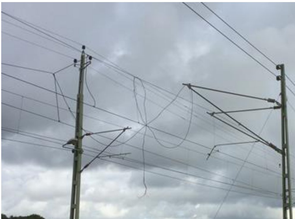
Bild 17. Nedriven kontaktledning.
