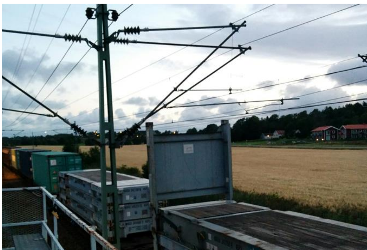
Bild 15. Vagnsgavel som lossnat och riskerar skada kontaktledningen.
