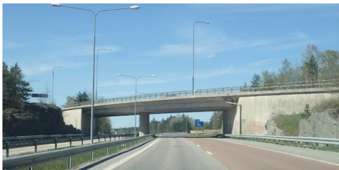
Figur 4:8 Bro 1-118-1 vid tpl Skrubba. En trolig sträckning av ny gång- och cykelväg är förhöjd där vägrenen är idag. Foto från BaTMan.
