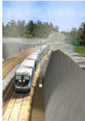
Figur 5.4 Studie av banvall med tåg visar utformning med en skärning i omgivande terräng. Bilden från Botniabanan.
