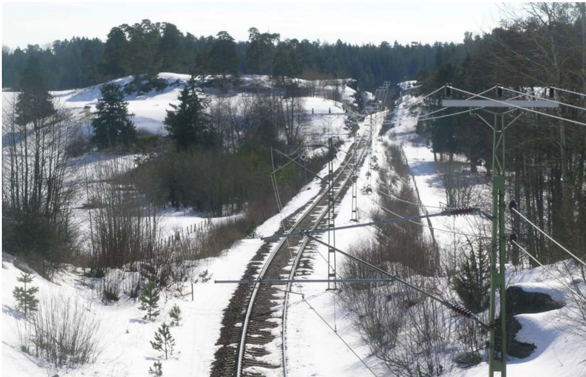
Den befintliga järnvägen vid Nora gård
