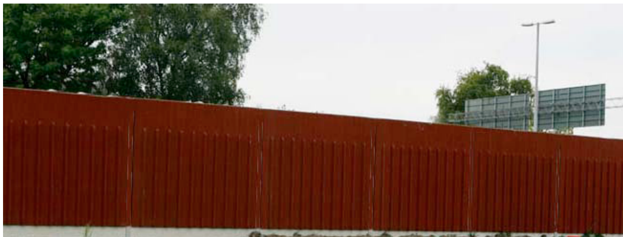
Exempel på bullerskydd med få uttrycksmedel samt jämn överkant..
