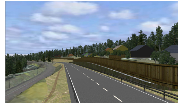
Vy mot söder med stödelement och bullerskydd till höger.
