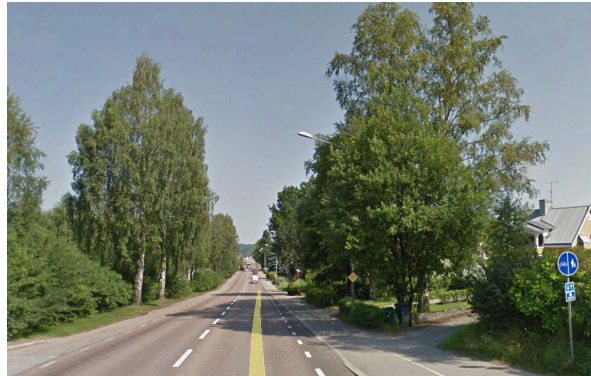
Befintlig situation. Raksträkan för södra delen med smalt vägrum som skapas av uppvuxen vegetation.
