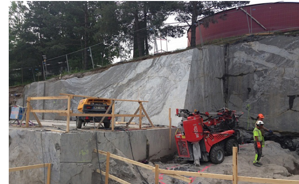
Exempel på sågning av berg där strukturen framträder.
