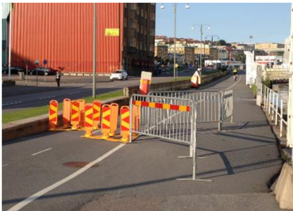
Figur 21. Chikan för cyklister kombinerat med kravallstaket för att undvika att cyklisterna genar över gångbanan. Foto: Johanna Aalto.
