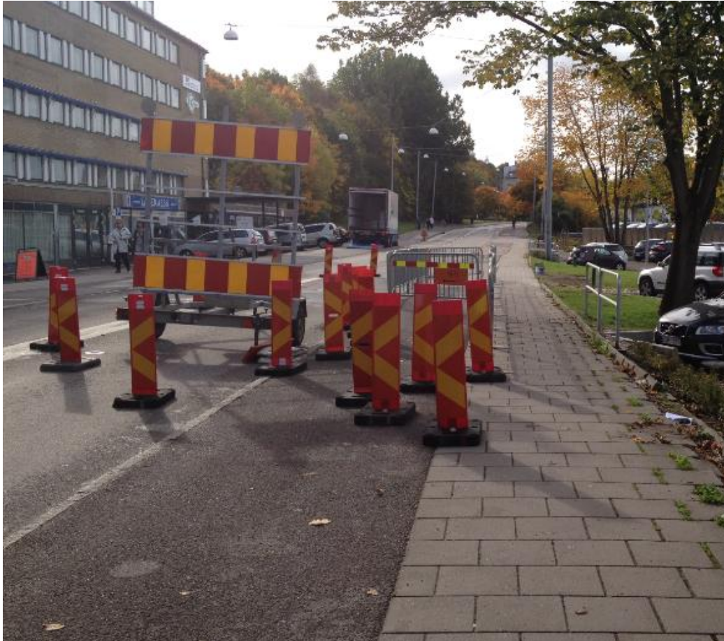
Figur 22. Hänvisningen ut i bilkörfältet till vänster i bilden missuppfattas och de flesta cyklistar väljer gångbanan till höger istället. Den omledning som fotot visar är densamma som schematiskt illustrerats i Figur 17. Foto: Johanna Aalto.
