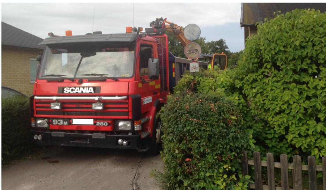
Figur 23. Arbetsfordon parkerat så att gång- och cykelvägen är helt blockerad, utan utmärkning och anvisning till alternativ väg (Figur 24).
