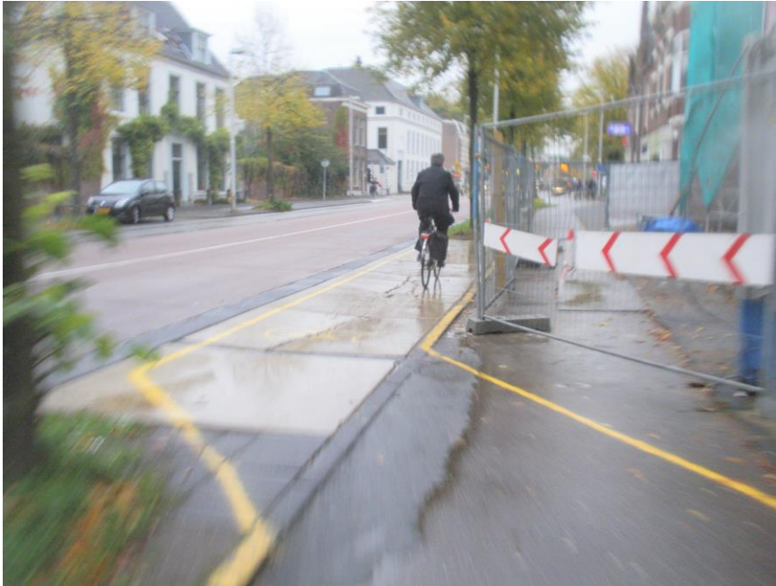
Figur 25. Tillfällig omledning av cykelbanan i samband med avstängning. Foto: Herbert Tiemens.
