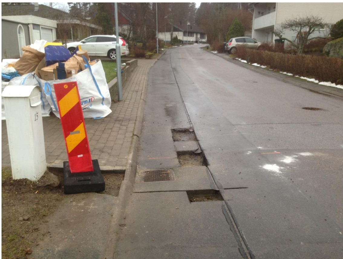
Figur 6. Djupa, omarkerade hål med skarpa kanter i beläggningen på en bostadsgata där cykling sker i blandtrafik.
